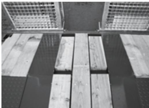
Стальной пол грунтирован и покрашен. Стальной пол может быть гладким, а также и из рифленного металла. Данной пол не нуждается в обслуживание. Повреждения верхней поверхности необходимо устранять. Пожалуйста обратите особое внимание на низкий коэффициент трения металла по металлу. В данном случае необходимо использовать резиновые прокладки.
